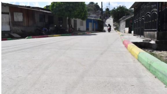
Las obras de pavimentación urbana avanzan en diferentes sectores de Barrancabermeja. Actualmente, los trabajos se concentran en barrios como María Eugenia y El Campín. Suministrada/Vanguardia
