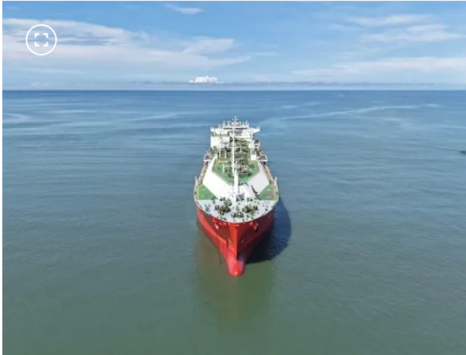
Regasificadora del Pacífico FOTO:REGASIFICADORA DEL PACÍFICO
